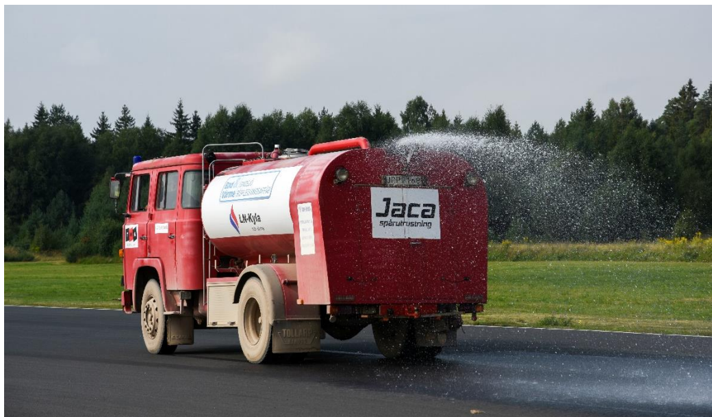
Figur 4. Bevattning av asfalten. Foto Mattias Hjort.
